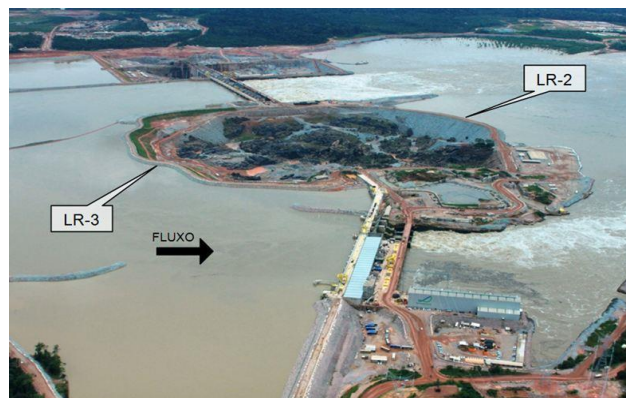
Figura 4.17. Vista del funcionamiento de la Obra de Desvío del Proyecto Santo Antonio.
