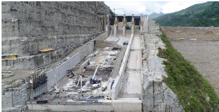
Figura 4.22. Avance del vertedor con respecto a la cortina del P. H. Ituango, Col.
