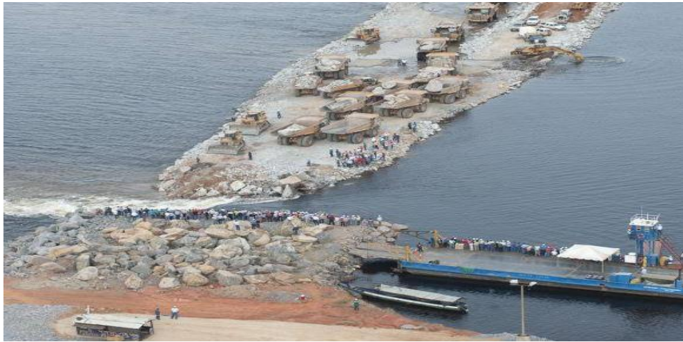
Figura 3.11 Cierre lateral para la presa Tocoma, Venezuela (tomada de http://www.skyscrapercity.com ).
