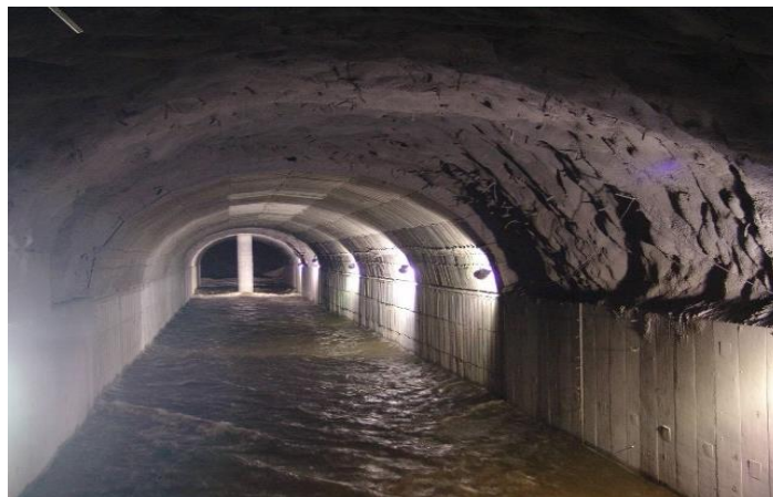
Figura 9.4 Condiciones constructivas del túnel de desvío.
