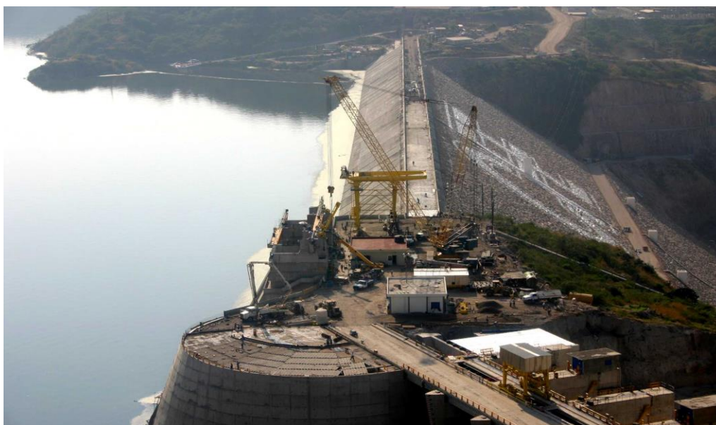
Figura 10.2 Imagen de las condiciones de la Cortina del P. H. El Cajón al momento del cierre final, las losas de concreto están a la Elev. 375.00 msnm.
