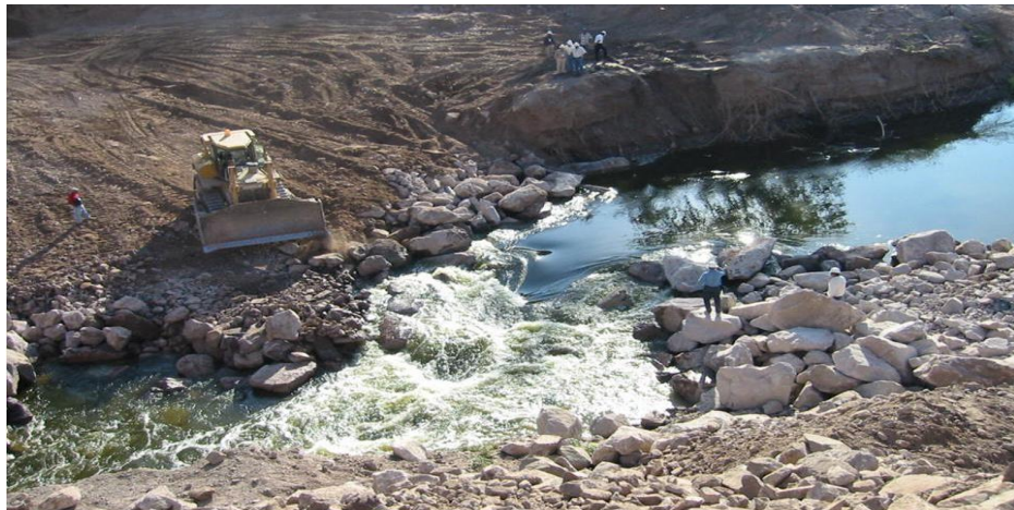
Figura 3.10 Cierre lateral, P. H. El Cajón.
