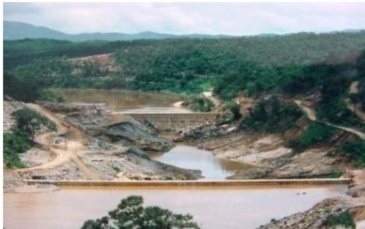
Figura 4.3 Ataguías de CCR de la Presa Serra de Mesa Brasil, 1990.
