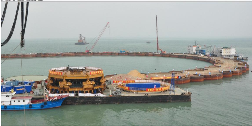
Figura 3.9. Ataguías celulares del puente túnel Hong Kong-Zhuhai-Macao Bridge (tomada de http://www.apevibro.com ).
