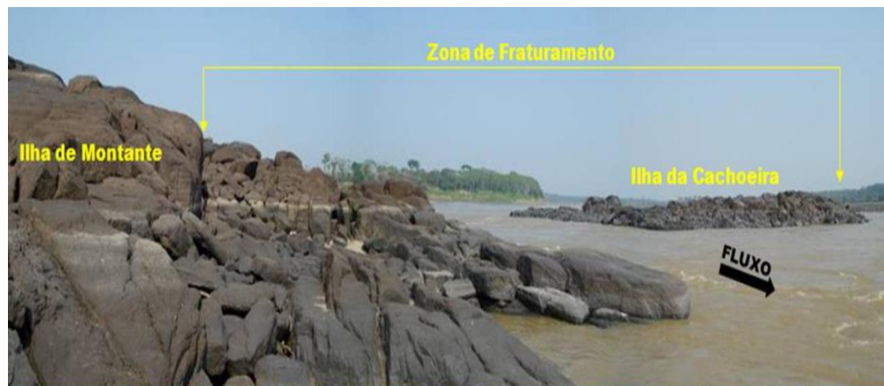
Figura 4.14. Roca de cimentación de la obra de Desvío del P. H. Santo Antonio.
