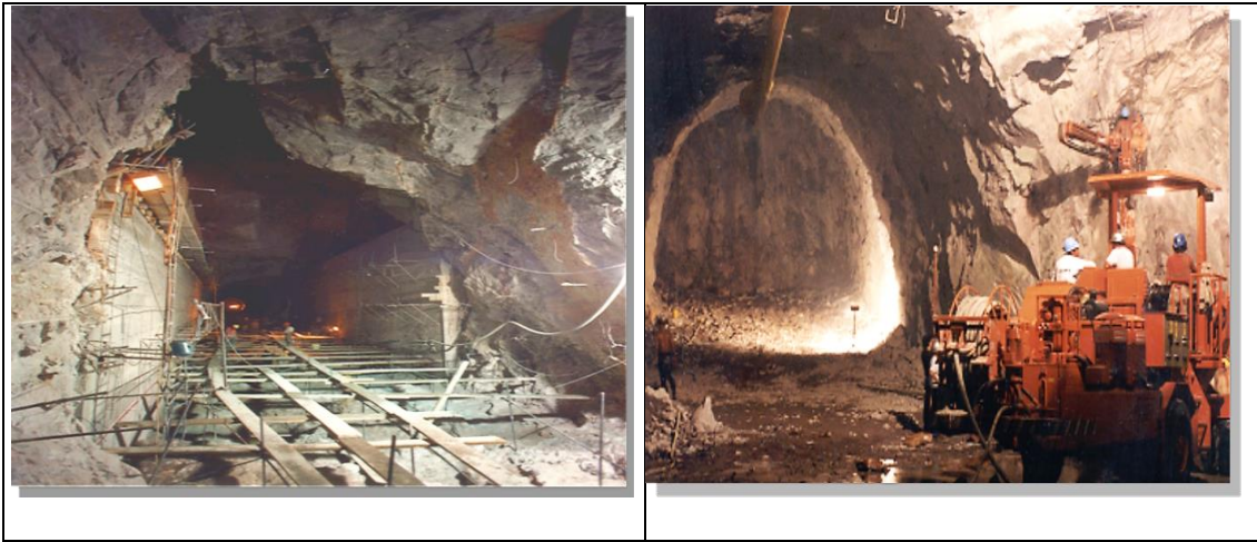
Figura 3.3 Tratamientos adicionales de los túneles del P. H. Aguamilpa, México.
