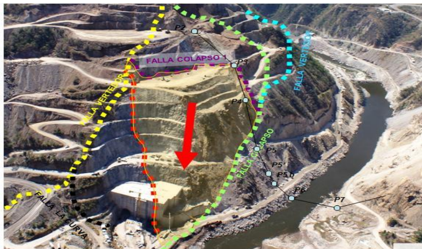
Figura 4.9. Vista general de las excavaciones de la obra de desvío del P. H. La Yesca.
