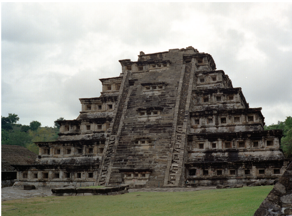
Figura 1.10 La foto muestra la pirámide por el costado este, el único que tiene una rampa construida encima de la estructura antigua. A causa de esta rampa, el conteo de los nichos no ha sido fácil, pero varios arqueólogos afirman que la pirámide nunca tuvo 365 nichos | © Latin Stock México.
