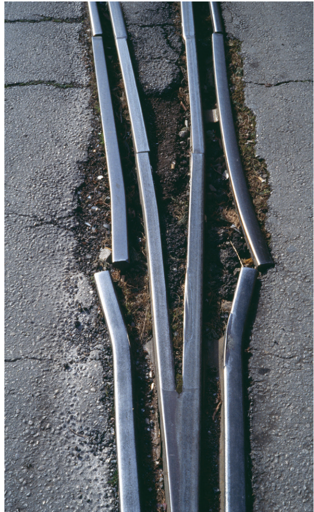
Figura 8. Vías torcidas en el punto de unión | © Latin Stock México.
