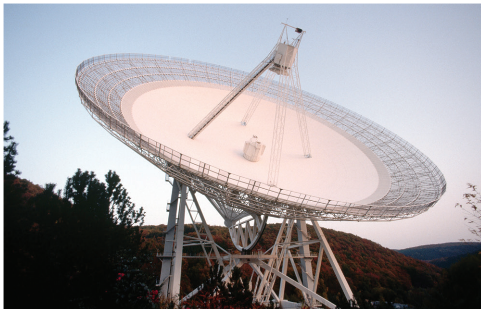
Figura 2.63 La antena de Effelsberg, un radiotelescopio de 100 metros de diámetro, es la más grande en Europa. Estos telescopios se diseñan para registrar señales electromagnéticas con frecuencias de 10 MHz a 100 MHz, lo que corresponde a longitudes de onda de 3 a 30 metros. Por ello, es posible usar mallas de metal para formar la superficie del reflector que concentra las ondas en el receptor. Para que las reflexiones lleguen a un solo punto —donde está el receptor— es necesario que la antena tenga una forma particular: que sea parabólica | © Latin Stock México.
