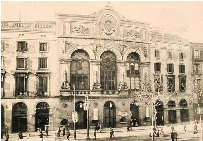
Figura 12. Fachada del Teatro de la Santa Cruz, Barcelona.
