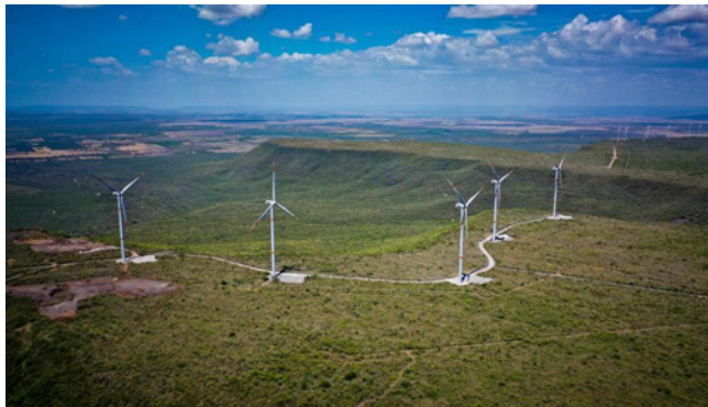
Figura 7.13. Parque Eólico Tres Mesas III (Fuente: SENER).
