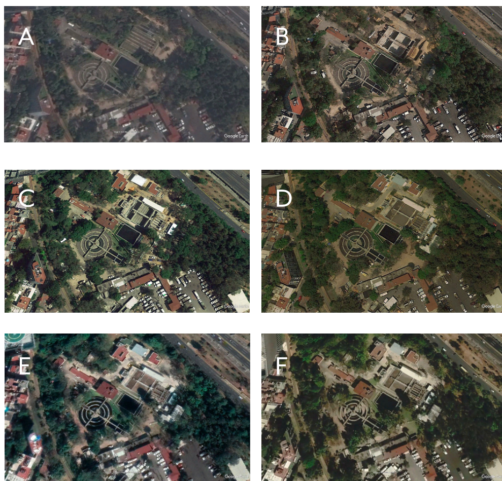
Figura 29. Proceso de construcción de la PTAR nueva de Chapultepec. En enero de 2016 (a) se aprecia la PTAR original de Chapultepec. En febrero de 2017 (b) y marzo de 2018 (c) se aprecia la PTAR nueva de Chapultepec en construcción. Para marzo de 2019 (d) la PTAR nueva de Chapultepec luce terminada y de acuerdo con las noticias ya se encontraba en funcionamiento. En enero de 2020 (e) y febrero de 2021 (f) la PTAR original de Chapultepec sigue apreciándose exactamente igual que desde 2016.
