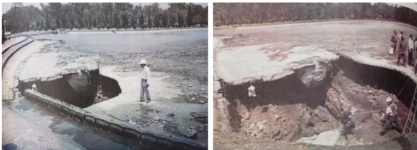
Figura 53. Grieta que condujo al vaciamiento del Lago Mayor el 5 de julio del 2006. (“¿Algún día el lago de Chapultepec se quedó sin agua?” México Travel Channel 26/08/2021, https://mexicotravelchannel.com.mx/estados/20210826/lago-de-chapultepec-artificial-seco-lago-mayor-historia/ ).
