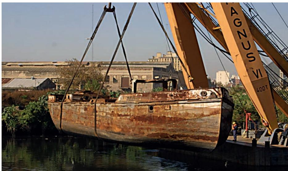
Figura 14. Extracción de buques hundidos, limpieza de espejo de agua. ACUMAR.
