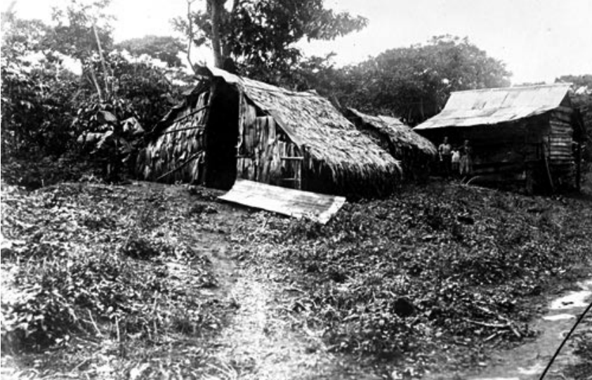
14. Casa de obrero en una finca alemana cerca de Alajuela, Costa Rica, julio de 1924, Bundesarchiv Bild 137 011-701 / fotógrafo: doctor Leopold.
