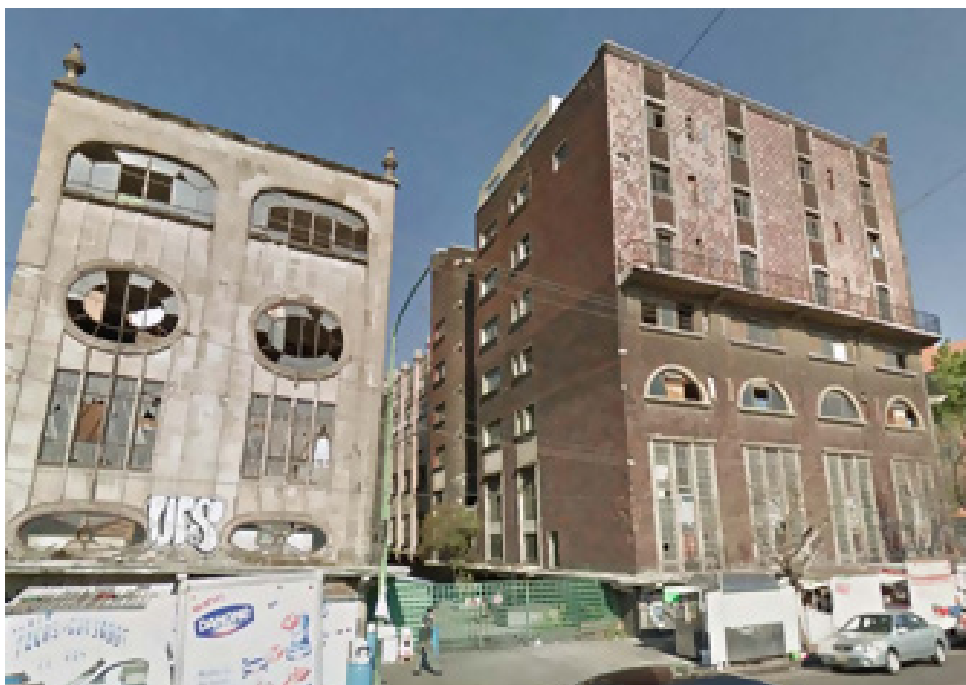
Imagen 1. Hotel Posada del Sol, edificio emblemático de la colonia Doctores que presenta un severo grado de deterioro.
