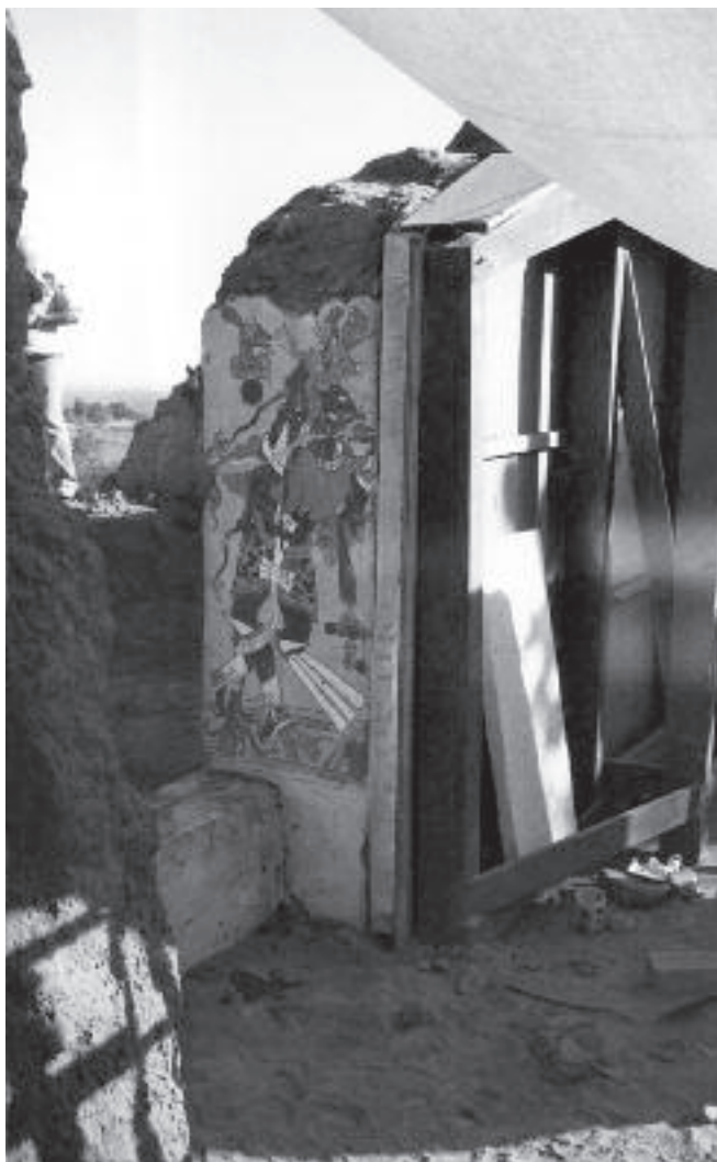
Figura 4.17. Sistema de protección con bastidores y materiales aislantes sobre la superficie de la pintura mural del Hombre Pájaro, que permitió realizar la excavación del recinto sin que se colapsara el muro con pintura tras haber liberado el vano y las jambas con pintura. (Foto: R. Peralta, octubre de 1975. Fototeca CNCPC-INAH.)
