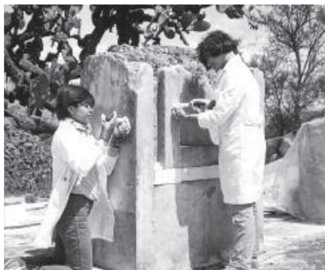
Figura 4.45. Trabajos de consolidación de los elementos arquitectónicos del Edificio E, durante una práctica de campo de los alumnos en 1984. (Foto: cortesía del Acervo Digital Fototeca CNCPC-INAH.)
