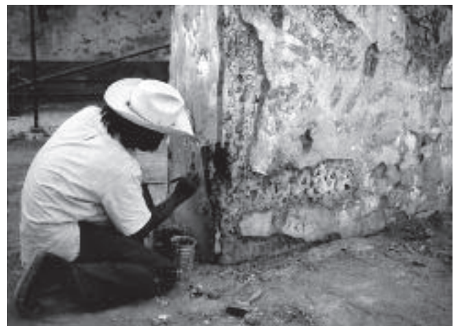
Figura 4.71. Aplicación de ribetes para fijar los restos de aplanado. (Foto: R. Peralta, junio de 1976. Fototeca CNCPC-INAH.)
