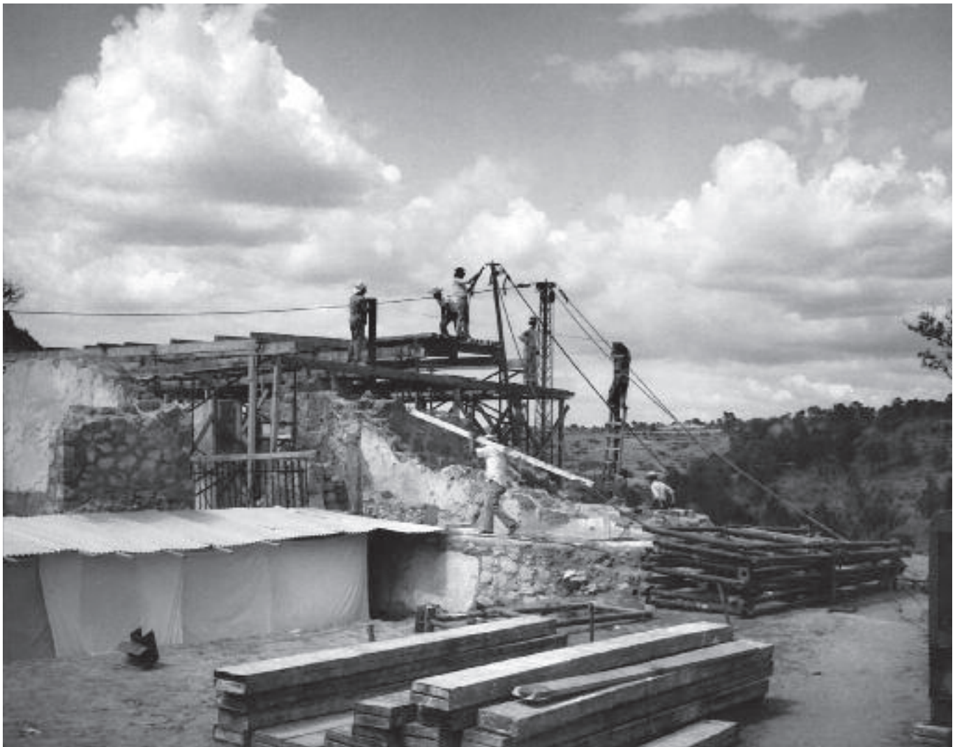
Figura 4.93. Trabajos de construcción de la cubierta de protección del Edificio A. (Foto: R. Peralta, agosto de 1976. Fototeca CNCPC-INAH.)
