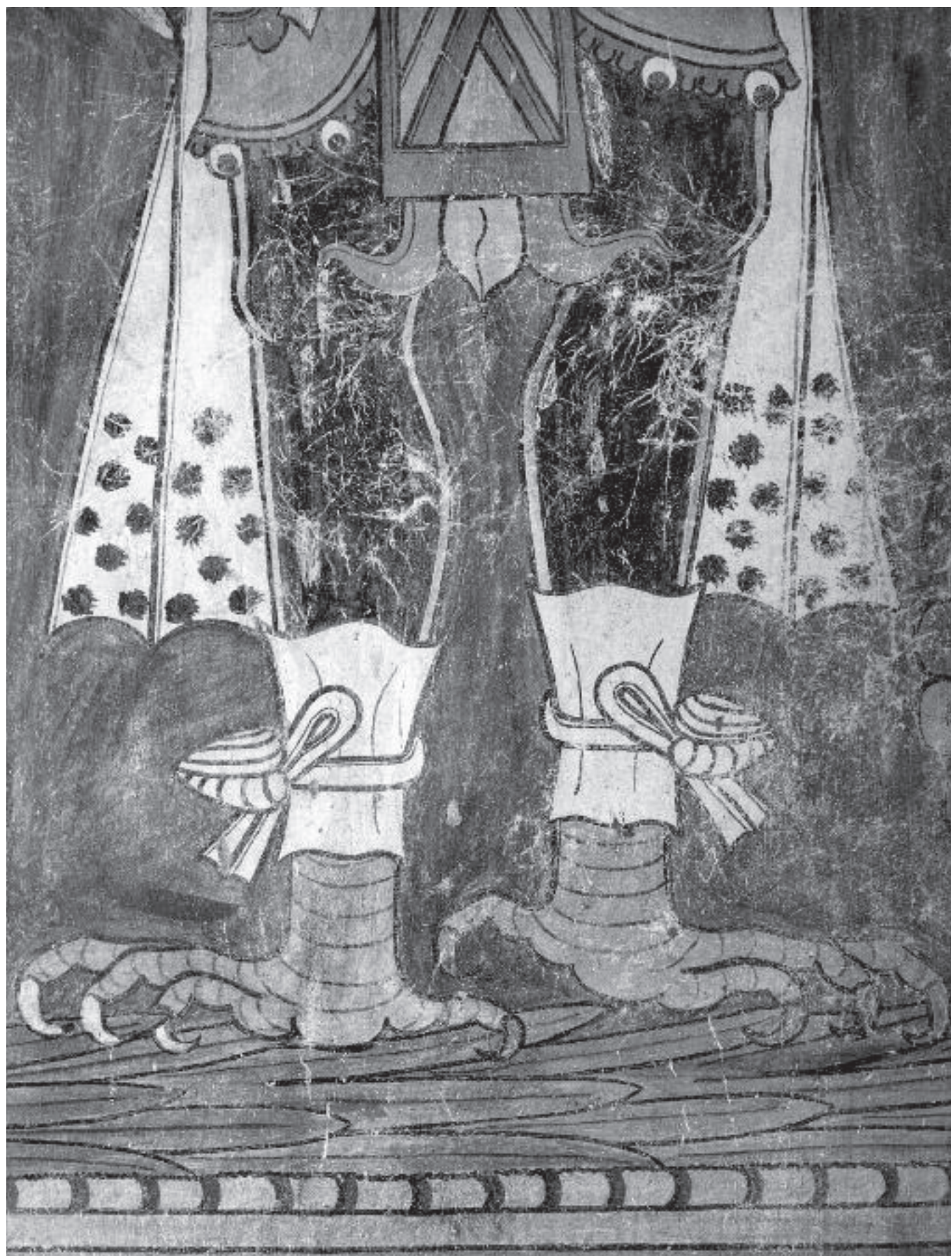
Figura 4.33. Superficie erosionada a causa del crecimiento de plantas y el anclaje de raicillas sobre la superficie pictórica. Esto puede apreciarse en las piernas del personaje Hombre Pájaro en el Edificio A.
