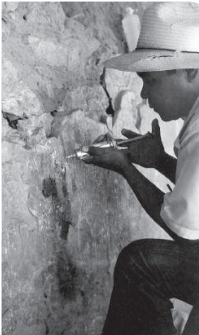
Figura 4.62. El restaurador Juan Hernández realiza tratamientos en el aplanado mediante inyecciones de solución consolidante. (Foto: R. Peralta, julio de 1976, Fototeca CNCPC-INAH.)
