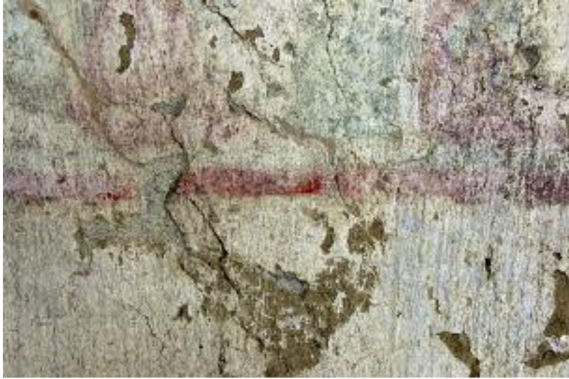
Figura 3.5. Cuarto de la Escalera, sección sureste del Basamento. La imagen permite ver que el muro de este cuarto, hecho con un aplanado de lodo, fue recubierto con una delgada capa de cal, a la que técnicamente se denomina lechada, sobre la cual se pintó con colores. Posiblemente el blanco de la lechada se aplicó para permitir un fondo claro y por consiguiente hacer los colores más luminosos. Se nota también la superficie texturizada del acabado, típica de Cacaxtla. (Foto: C. Brittenham, 2009.)
