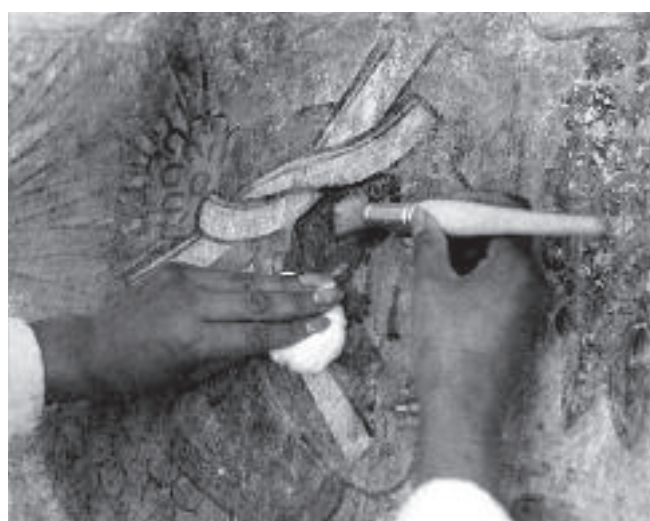
Figura 4.66. Aplicación de pruebas de limpieza con pastas desincrustantes o papetas propuestas por el químico del DRPC-INAH. (Foto: J. R. Ramírez, marzo de 1978. Fototeca CNCPC-INAH.)
