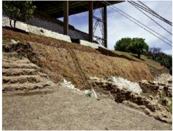
Figura 4.104. Pasto sembrado sobre las áreas no exploradas alrededor del basamento y una muestra de la aplicación de capas de sacrificio que cubren los muros expuestos, para proteger el material original del soporte. (Foto: R. Alvarado y T. González, 2011.)
