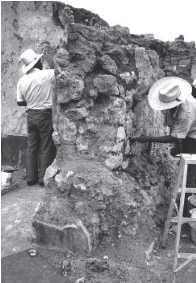
Figura 4.70. Trabajos en la consolidación de muros, mediante la aplicación de un consolidante. (Foto: R. Peralta, mayo de 1976. Fototeca CNCPC-INAH.)
