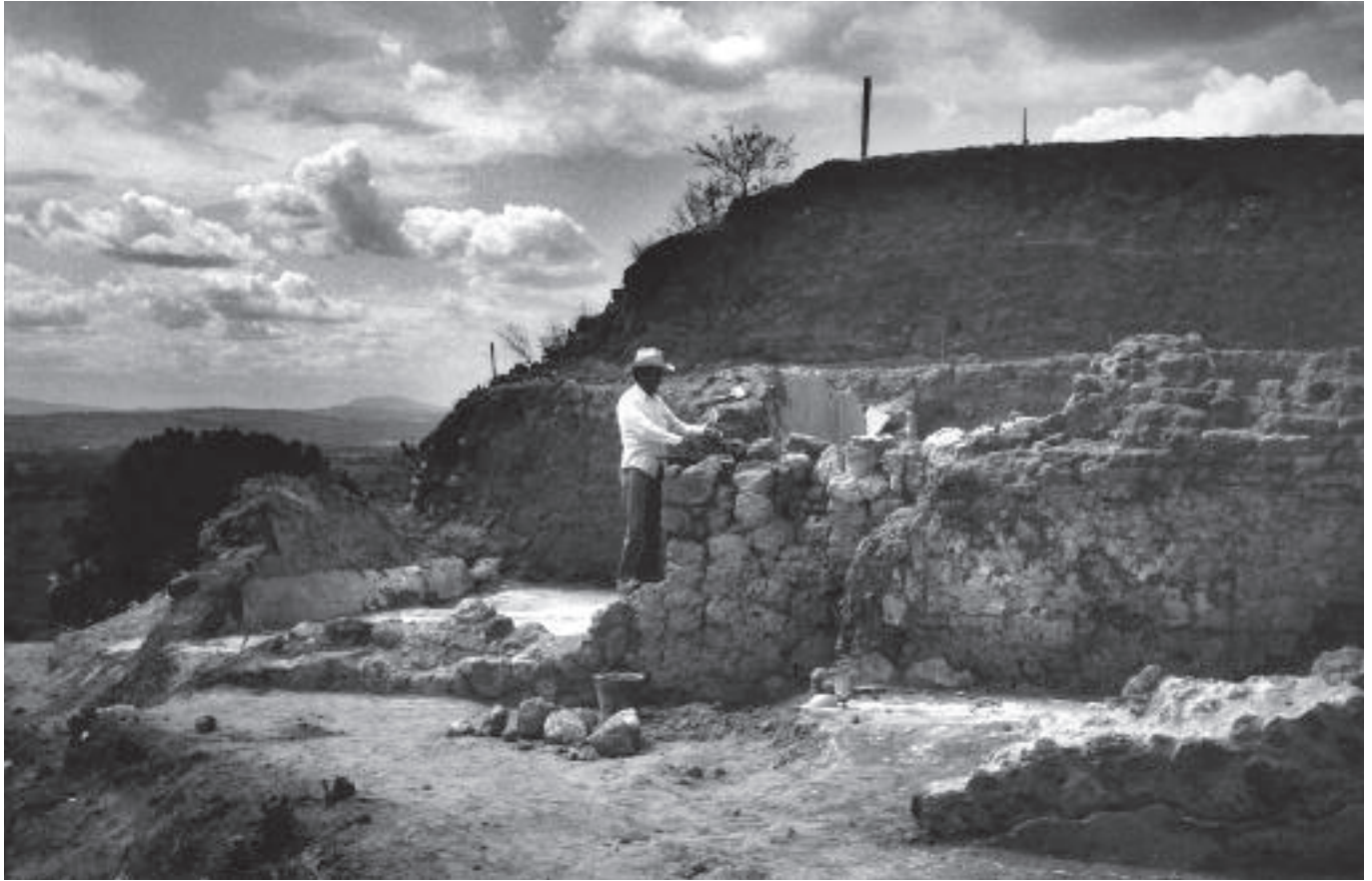
Figura 4.69. Trabajos de consolidación de muros en el Gran Basamento de Cacaxtla. (Foto: R. Peralta, julio de 1976. Fototeca CNCPC-INAH.)
