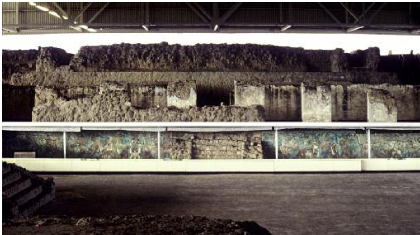
Figura 4.101. Vista de la fachada del Edificio B desde la sección sur de la Plaza Norte, la cual puede verse bajo la gran techumbre, la cubierta de protección de las pinturas de La Batalla y el andador que cubre cierta altura de los murales. En la actualidad esta cubierta ha sido eliminada. (Foto: D. Magaloni, 1990.)
