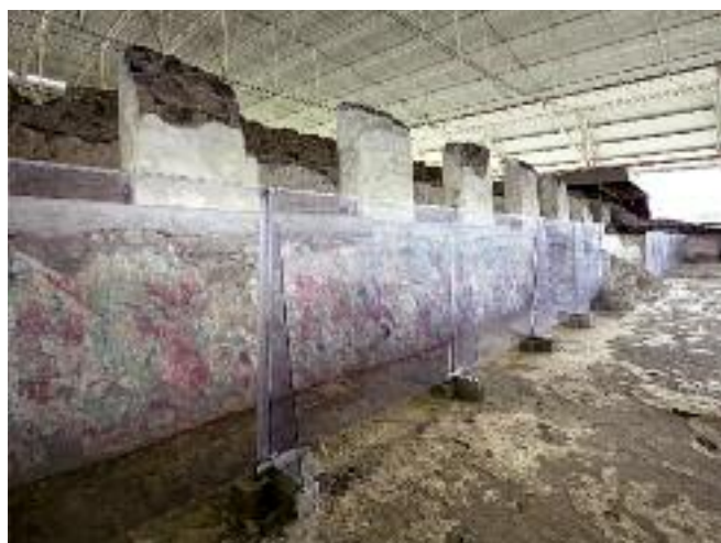
Figura 4.102. Protección de policarbonato fijada frente a las pinturas para reducir el impacto del viento sobre la superficie. (Foto: R. Alvarado y T. González, 2011.)
