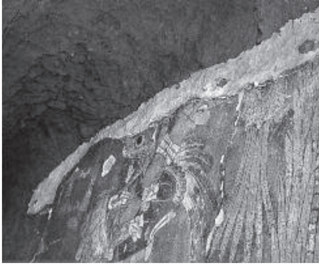
Figura 4.47. Aplicación de mortero en la parte superior del muro para evitar su desplome y poder realizar el trabajo arqueológico. (Foto: R. Peralta, noviembre de 1975. Fototeca CNCPC-INAH.)
