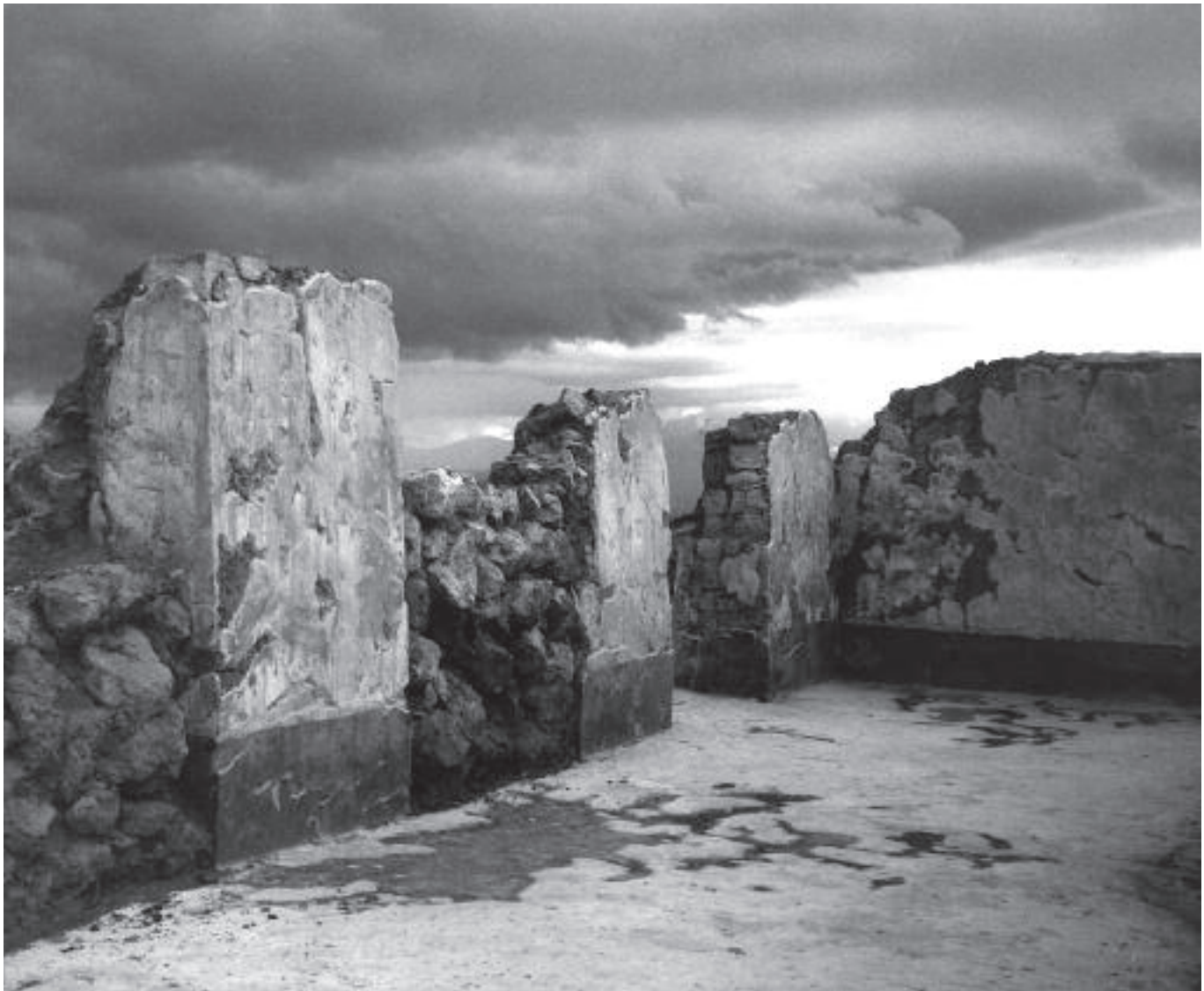
Figura 4.41. Relleno constructivo con piedra y arcilla en los vanos entre las pilastras del Edificio B. (Foto: R. Peralta, julio de 1976. Fototeca CNCPC-INAH.)
