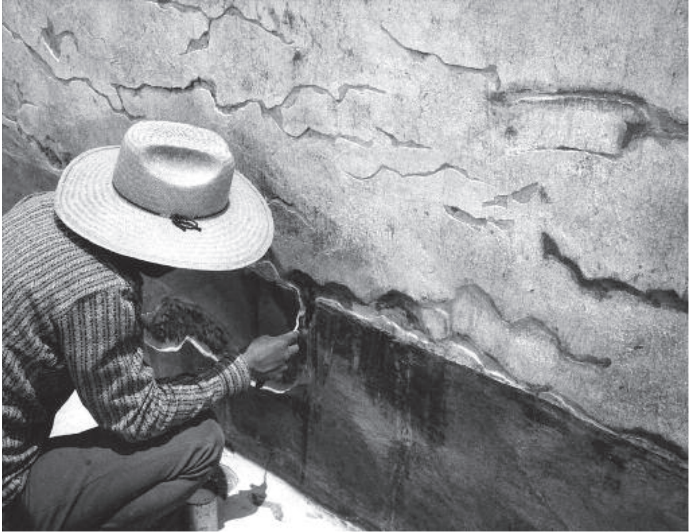
Figura 4.72. Aplicación de resanes y ribetes en las grietas y faltantes del aplanado. (Foto: R. Peralta, mayo de 1976. Fototeca CNCPC-INAH.)
