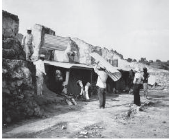
Figura 4.95. Trabajos de construcción de la cubierta temporal para proteger las pinturas de La Batalla, durante la exploración de la subestructura del Edificio B. (Foto: R. Peralta, mayo de 1976. Fototeca CNCPC-INAH.)
