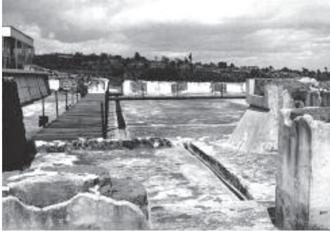
Figura 4.75. Drenajes realizados en la Plaza Norte y el Edificio E, para liberar el agua que se encharcaba frente a los murales de La Batalla. (Foto: cortesía del Acervo Digital Fototeca CNCPC-INAH.)
