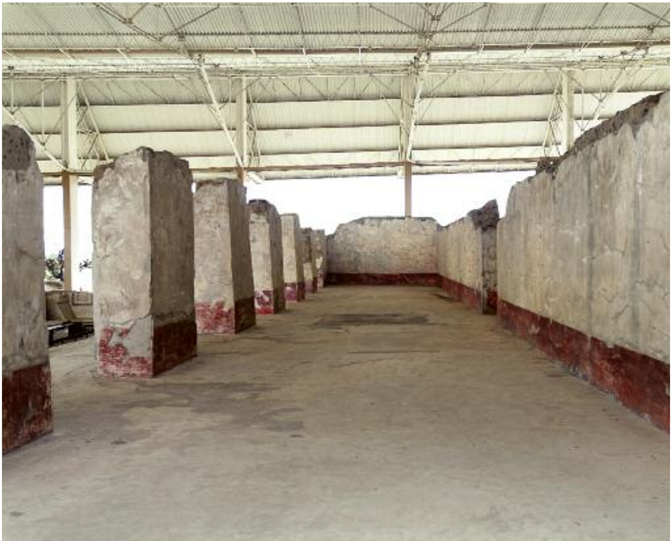
Figura 1.85. Edificio B, guardapolvo. (Foto: P. Peña, 2008.)
