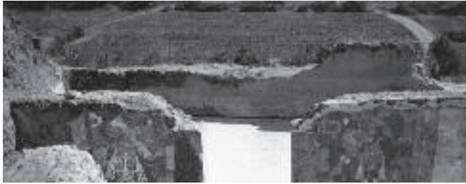
Figura 4.54. Muro este, en el interior del recinto del Edificio A. En este muro fueron descubiertas las pinturas de las Serpientes Entrelazadas, posterior a un proceso de limpieza y descarbonatación. (Foto: R. Peralta, diciembre de 1975. Fototeca CNCPC-INAH.)
