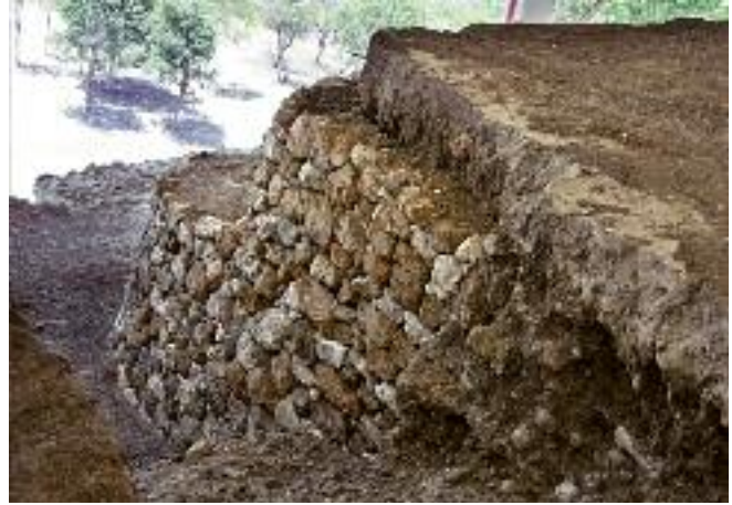
Figura 4.76. Posible sistema de núcleo expuesto, que sirve a manera de muro de contención sobre los vestigios arquitectónicos. (Foto: R. Alvarado y T. González, 2011.)
