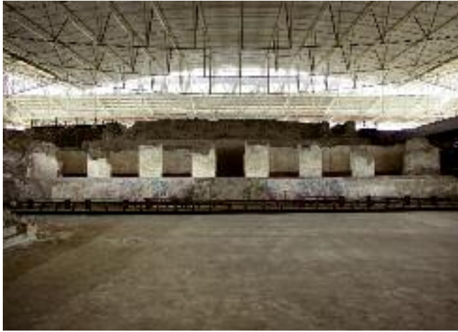
Figura 2.11. El Edificio B de Cacaxtla posee en su talud inferior el llamado mural de La Batalla. La escalinata central define su eje de simetría y está dirigida hacia el sur. (Foto: J. Galindo.)
