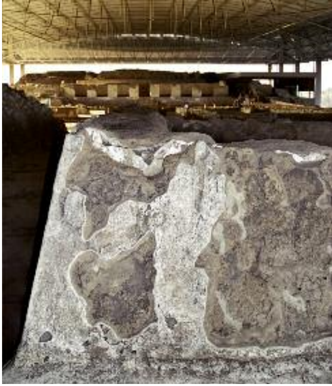
Figura 1.84. Detalle de pintura mural en el Palacio. (Foto: R. Alvarado, 2008.)
