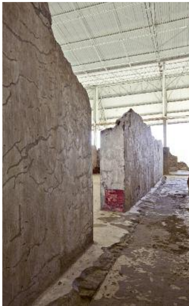
Figura 2.23. Parte trasera del Edificio B donde se aprecia la altura original de los muros. Sobre éstos se colocó la techumbre; de esta forma se tendría la altura total del edificio. (Foto: R. Alvarado y T. González, 2011.)
