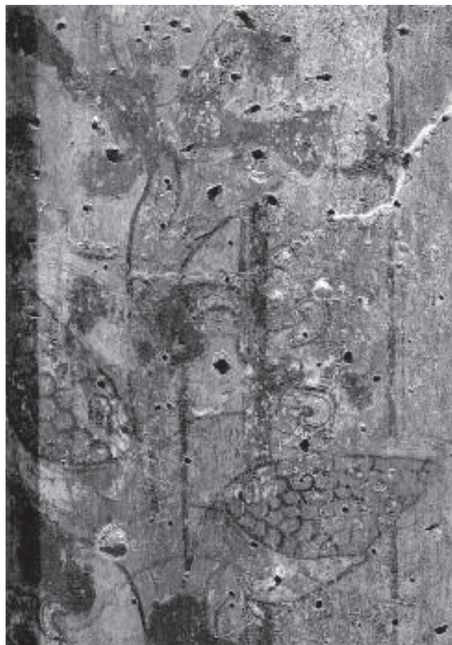
Figura 4.38. Detalle del picado de la superficie pictórica en el muro del Hombre Pájaro, con objeto de permitir un mejor anclaje del relieve de barro; además, puede apreciarse la línea base del dibujo que utilizaron para realizar esta aplicación. Este acabado fue resultado de la reutilización del muro pintado en una segunda etapa decorativa. (Foto: I. Groth, marzo de 1976. Fototeca CNCPC-INAH.)
