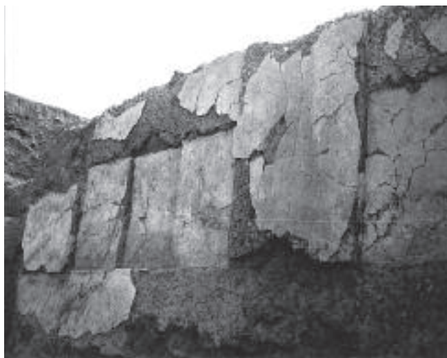
Figura 4.30. Paramento con elementos decorativos en forma de tableros, con pérdidas del aplanado de cal que deja a la vista el firme de tierra rejoneado con gravas. (Foto: R. Peralta, mayo de 1976. Fototeca CNCPC-INAH.)
