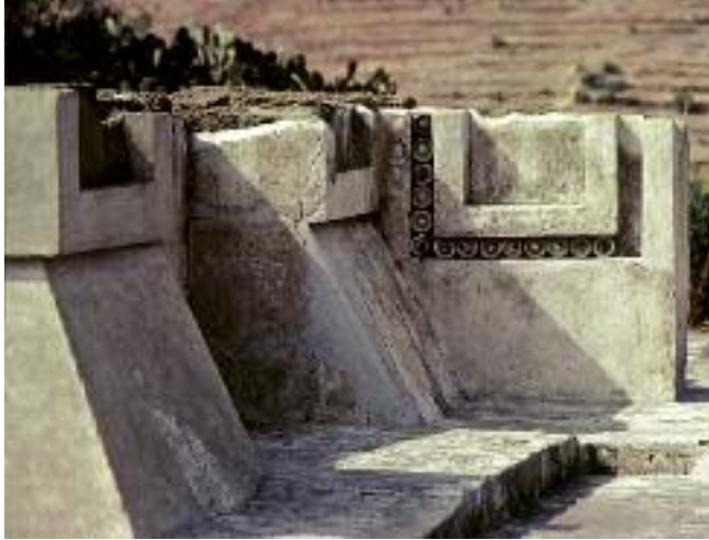
Figura 1.31. Edificio E, talud-tablero. (Foto: G. Griffin.)
