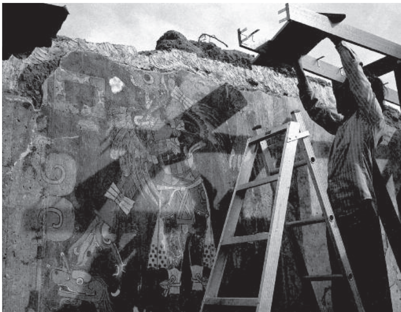
Figura 4.18. Al terminar la liberación del Edificio A, se desarmó el andamio que servía de soporte al bastidor de protección. (Foto: R. Peralta, diciembre de 1975. Fototeca CNCPC-INAH.)
