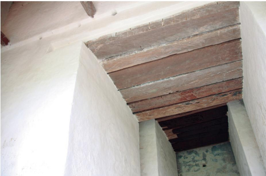
Figura 22. El dintel 2 (colocado por la Universidad de Pennsylvania) al frente y, al fondo, el dintel 3 (réplica del PANAT) sobre las vigas. Foto: S. Morselli, julio de 2010.
