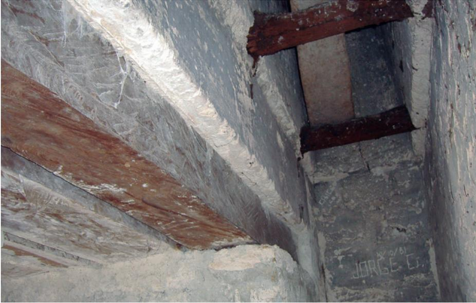
Figura 21. Las vigas de chicozapote colocadas por la Universidad de Pennsylvania a principios de 1980.
