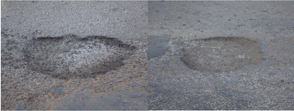
Figura 6. Painéis nos Trechos 03 e 05
