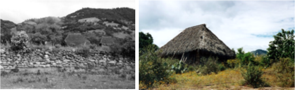
Figura 10. a) unidades domésticas tradicionales erigidas sobre plataformas prehispánicas reutilizadas y nivelada con piedra y tierra apisonada, b) materiales constructivos para el techo hojas de palma ( Brahea dulcis ), postes y soportes el ocote ( Pinus sp.), y para las paredes de bajareque, carrizos ( Croton sp.) y lodo (Flores, 2003).
